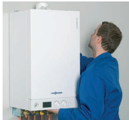
2. Montage de la chaudière
